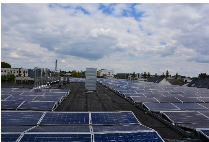
Abbildung 2: Dachansicht Ökobäckerei Mauerer
